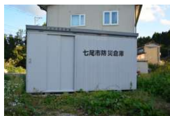
↑防災倉庫（池崎町）
